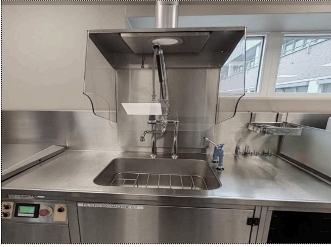
Şekil 2.7. Koruyucu bariyerli yıkama lavabosu
