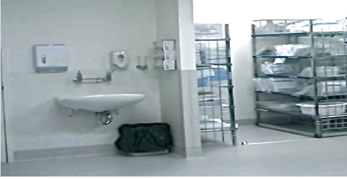
Şekil 2.3 Alanlar arası geçiş noktasında el yıkama lavabosu.
