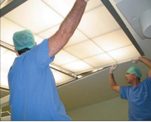
1. Laminatörün sökme işlemi
