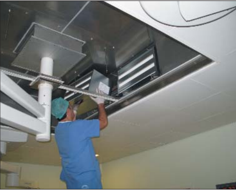
3. HEPA filtrelerin çıkarılması
